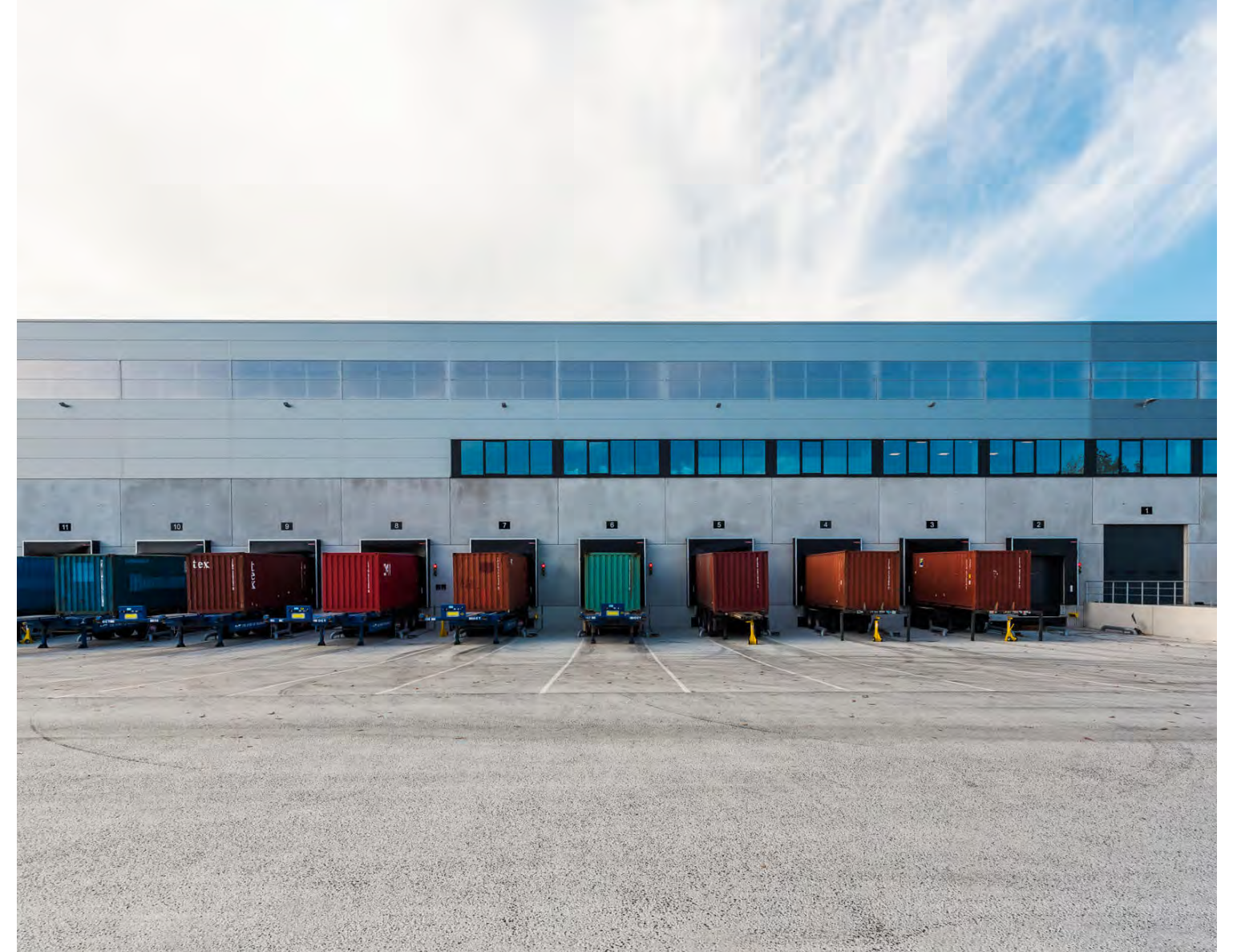
Architect: Convexarchitecten, foto: BEELD31
